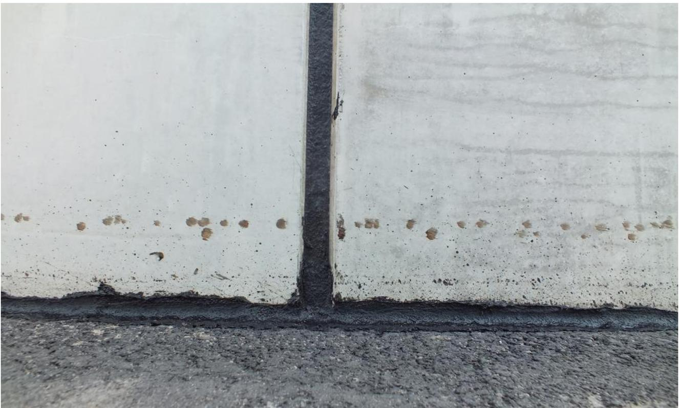
**Bild 6:** Ausführung nicht befahrener Boden- und Wandfuge (Materialverträglichkeit bei Fugenstößen beachten)
