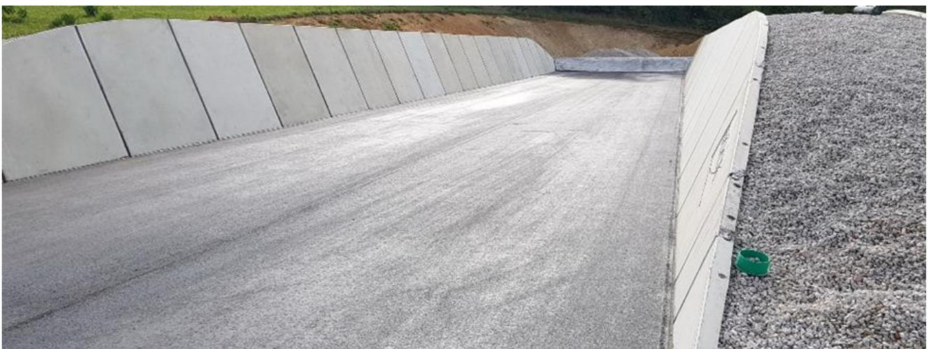
**Bild 11:** Asphalt - Betonfertigteil (Traunsteiner Wand); weitere Details siehe abZ/aBG, Anlage 1 - 6 (Quelle: Ronald Kriz, Böck Silosysteme GmbH)
