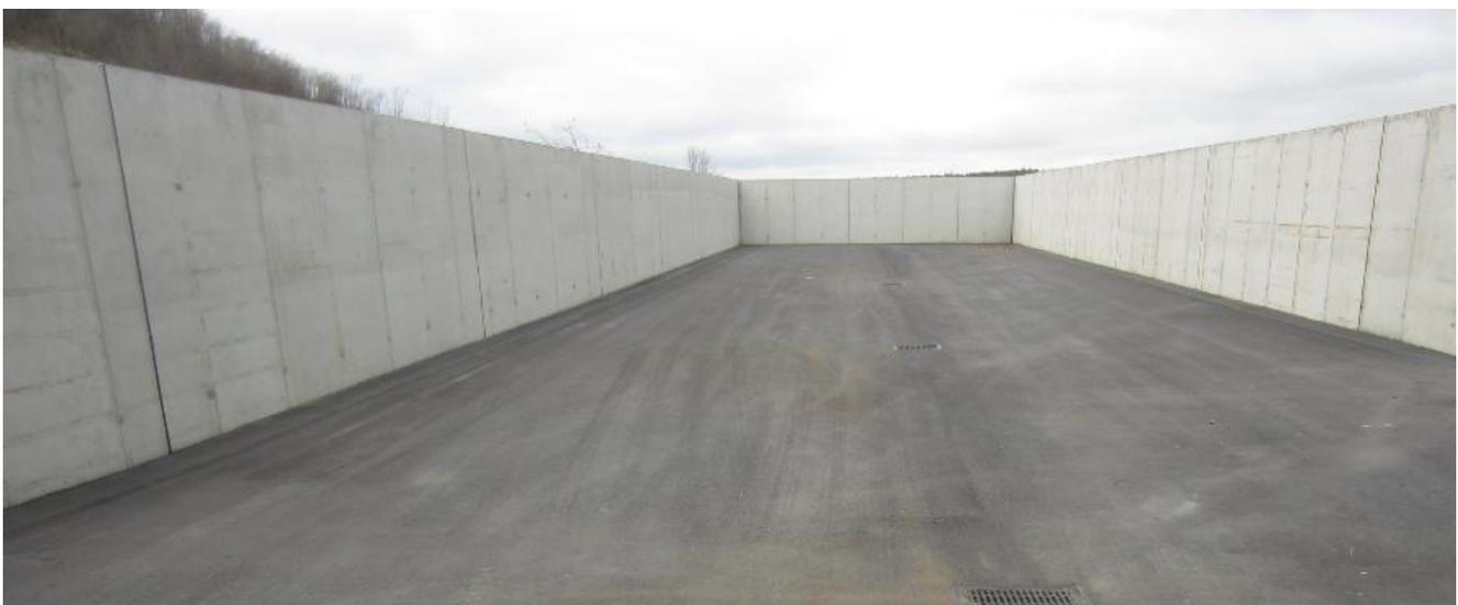
**Bild 9:** Asphalt - Ortbeton (gerade Wand) (Quelle: Klaus Hoffmann)
