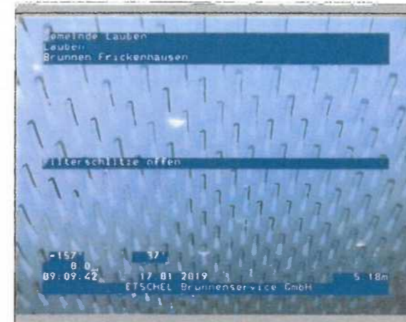
Foto: 1_1_9_17012019_090814_A.JPG 5,18m, Filterschlitz offen
