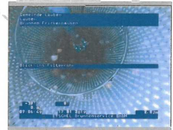
Foto: 1_1_6_17012019_090520_A.JPG 2.82m, Blick ins Filterrohr
